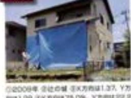
①2008年 ②住宅 ③X方向は1.37、Y方向は1.28 ④X方向は75.0%、Y方向は29.2% ⑤柱付け耐かい建物使用、HO建物が存在 ⑥1.5Pと2Pは確認できない ⑦盛り土、敷居地盤、築の間に地盤沈下 (写真: 国土院)
