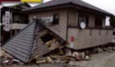
①2006年 ②住宅 ③X方向は1.04、Y方向は1.07 ④X方向は50.0%、Y方向は34.5% ⑤耐かいが不明、柱付け耐かい建物使用 ⑥1.5Pと2P使用 ⑦敷居あり、築家が倒れかけた盛り土
