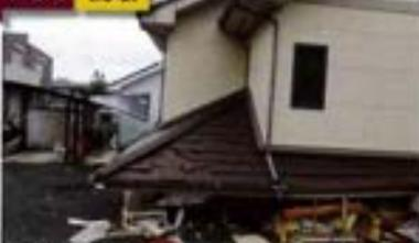
①2001年 ②住宅 ③X方向は1.49、Y方向は1.42、耐かいが不明 ④X方向は7.5%、Y方向は56.2% ⑤HO建物のアンカーボルトが埋め ⑥2P使用 ⑦盛り土、敷居地盤、地盤あり
