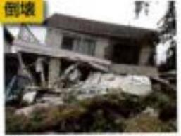
①2000年 ②住宅 ③X方向は1.45、Y方向は1.67 ④X方向は26.7%、Y方向は29.2% ⑤ボックス型耐かい建物使用、HO建物が確認できない ⑥不明 ⑦南向きに地盤が下がる (写真: 国土院)
